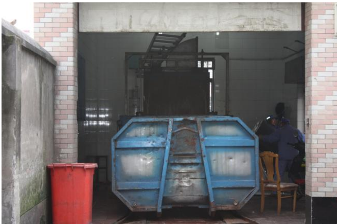
图 2-4 虹口区小型垃圾压缩站
